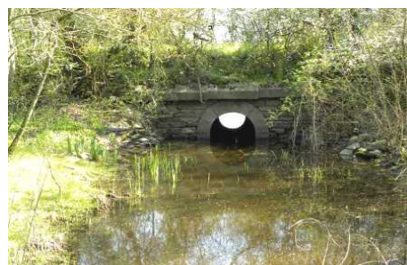
Le pont de pierre enjambant l'évacuation des « fouilles »
